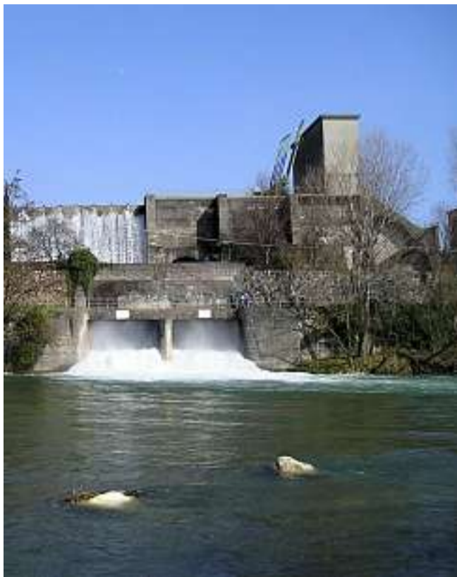
La centrale idroelettrica di Ca' Barzizza
