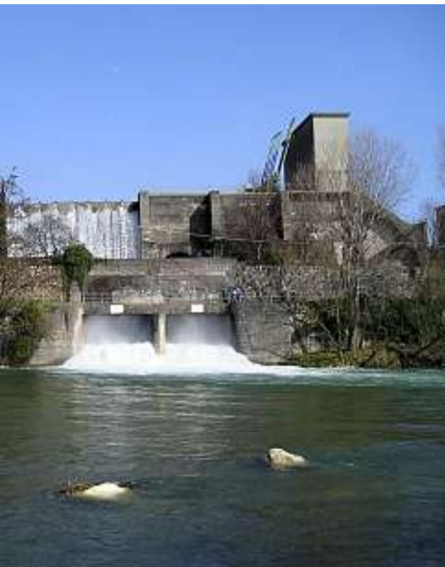
La centrale idroelettrica di Ca' Barzizza
